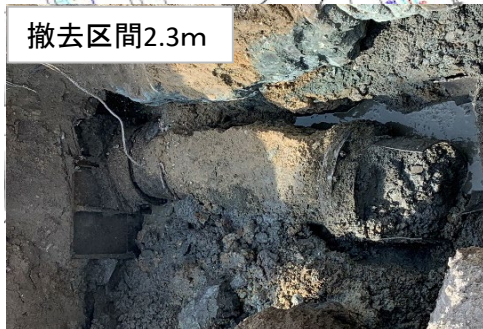
使用中止 (モルタル充填) DIP φ500 L=0.1m
