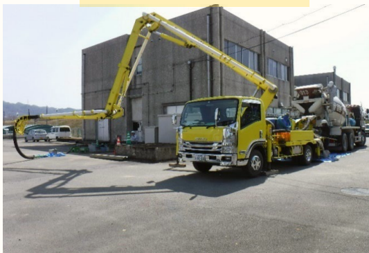
コンクリートポンプ車による注入状況
