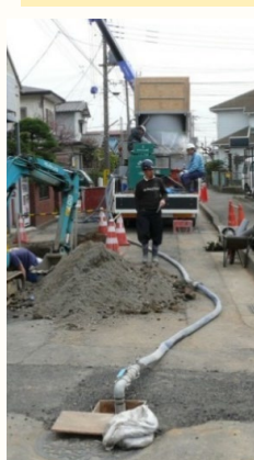
プラント車配置状況
